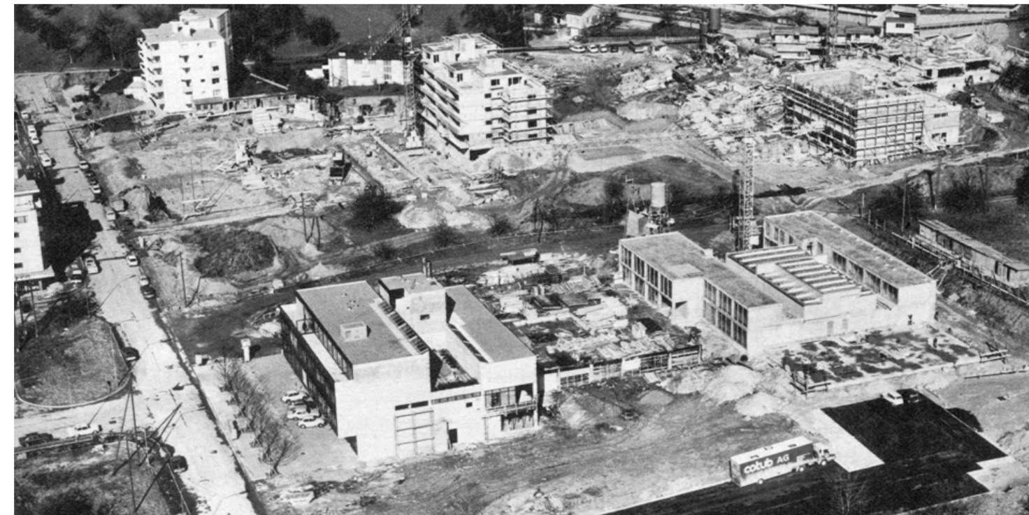
Das Zentrum – eine grosse Baustelle
