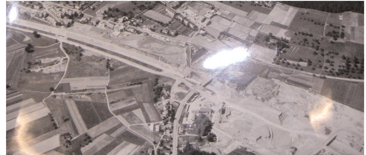
Bau Autobahn A1 Zürich–Bern bei Geroldswil.
