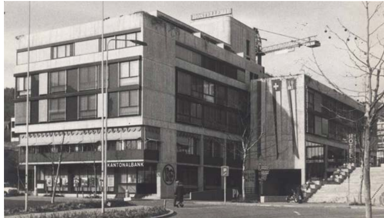
Abb. 13: Ansicht Hotel, Foto 1977
