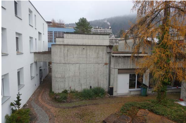
Abb. 18: Gasse zur Poststrasse (Foto: Baumberger & Stegmeier Architekten)
