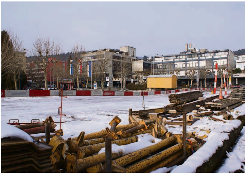
Der Kiesplatz im Zentrum soll bald zur Baustelle werden.
