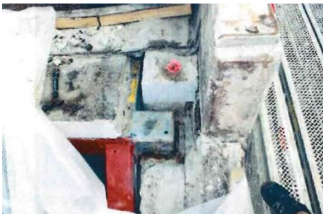
Hauptträger 7: Seitenfläche ca. 3mm Querschnittverlust
