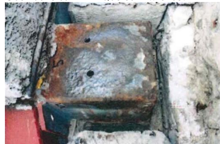
Hauptträger 5: Oberfläche ca. 2mm Querschnittverlust
