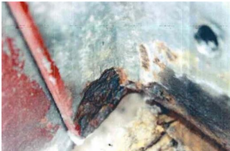
Hauptträger 7: Seitenfläche ca. 3mm Querschnittverlust
