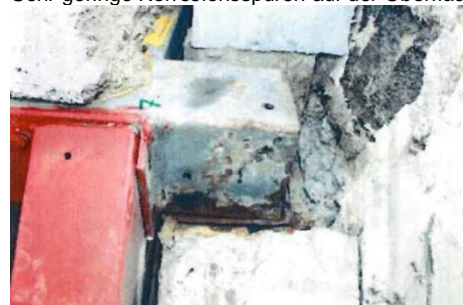
Hauptträger 7: Aussenfläche teilweise komplett durchkorrodiert
