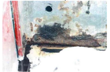
Hauptträger 7: Aussenfläche teilweise komplett durchkorrodiert
