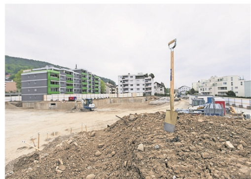
Baufeld Ost: Auf diesem Areal steht ab 2020 der neueste Limmattaler Zentrumsbau.
